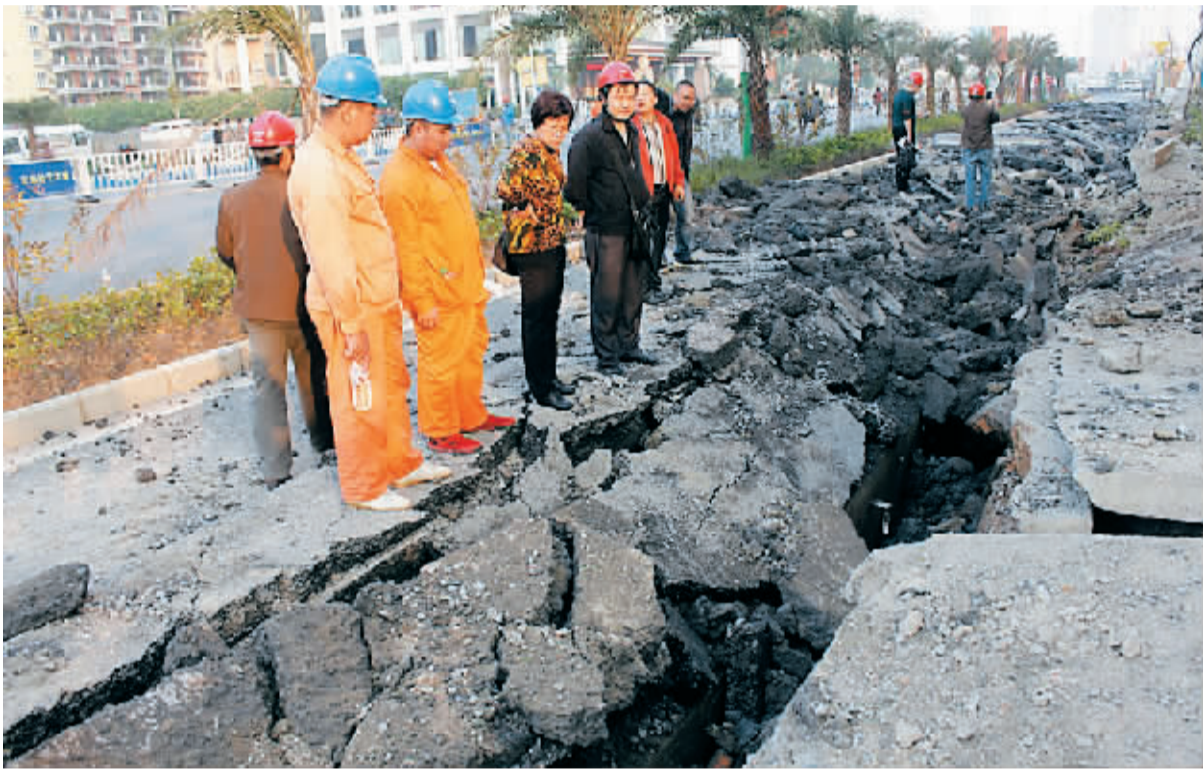
2013年1月23日，广西北海市金海岸大道非机动车道一处埋有燃气管道和高压电缆的地下管道发生爆炸，沿路约80米水泥盖板被掀翻。
