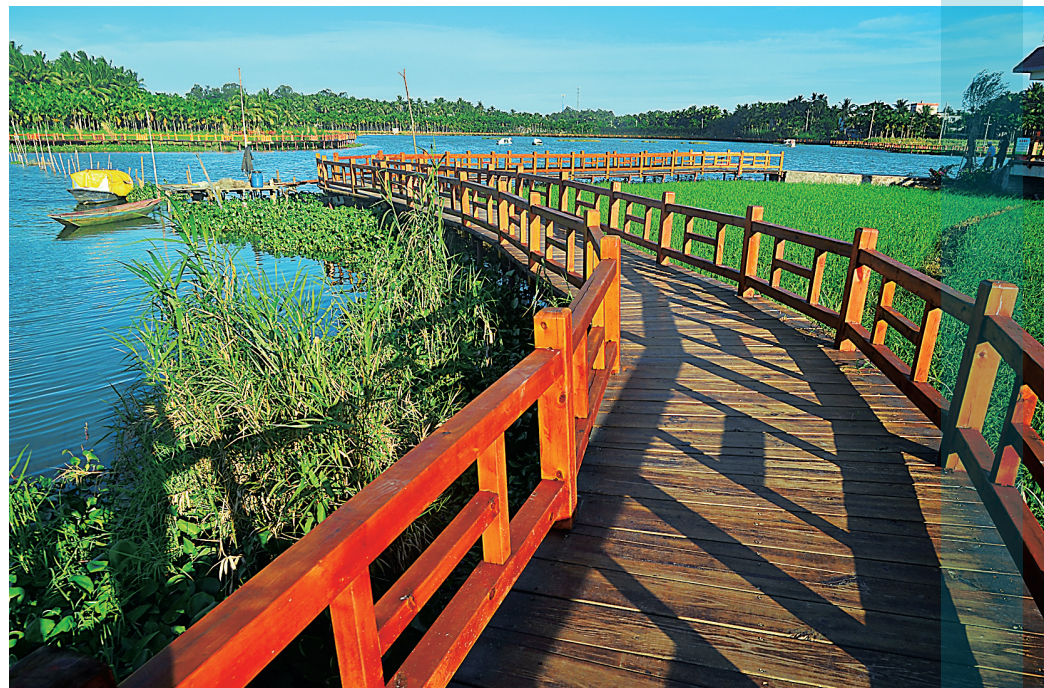
琼海塔洋七星伴月景区的环湖栈道。
