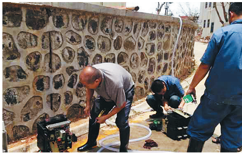
24日下午，三亚市的支援队伍在海甸三西路水岸银湾小区抢修供水。
