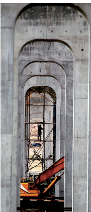
7月28日，西环高铁施工现场。 本报记者 陈元才 摄
