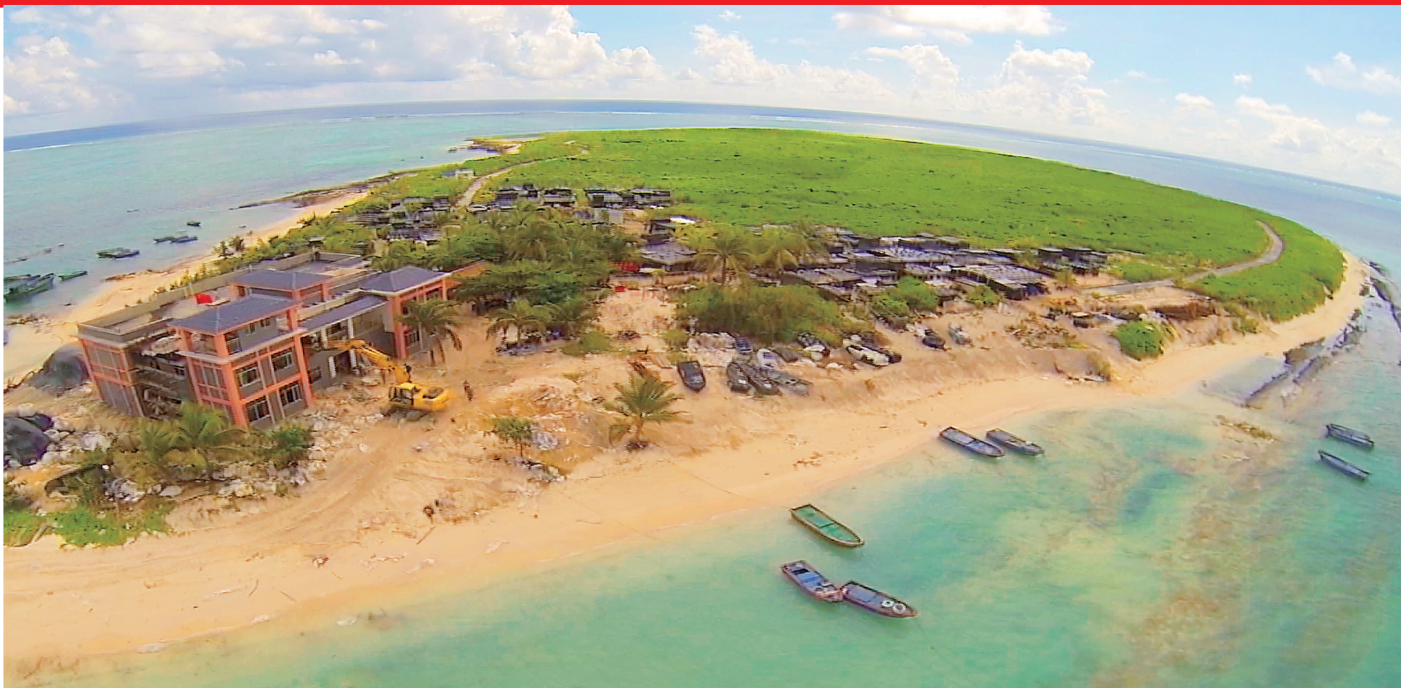
2014年7月23日，三沙市赵述岛居委会办公楼竣工。
