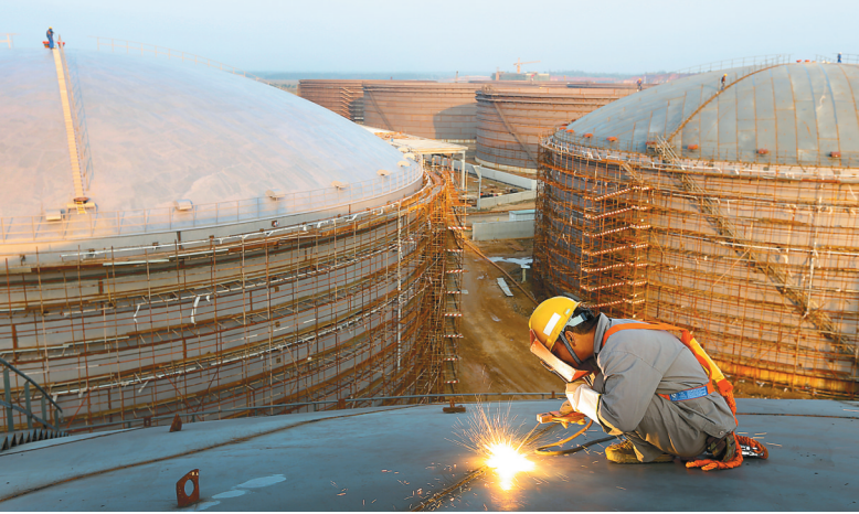
海南华信油储项目建设超七成 一名技术工人近日在焊接10万立方米储油罐罐顶。 记者日前了解到，经过两年时间的准备和一年时间的紧张建设，海南华信石油储备基地完成总工程量的72%。预计明年4月中旬实现中交，项目投入使用后计划每年输送石油总量1200万吨。 本报记者 苏晓杰 通讯员 罗其才 摄
