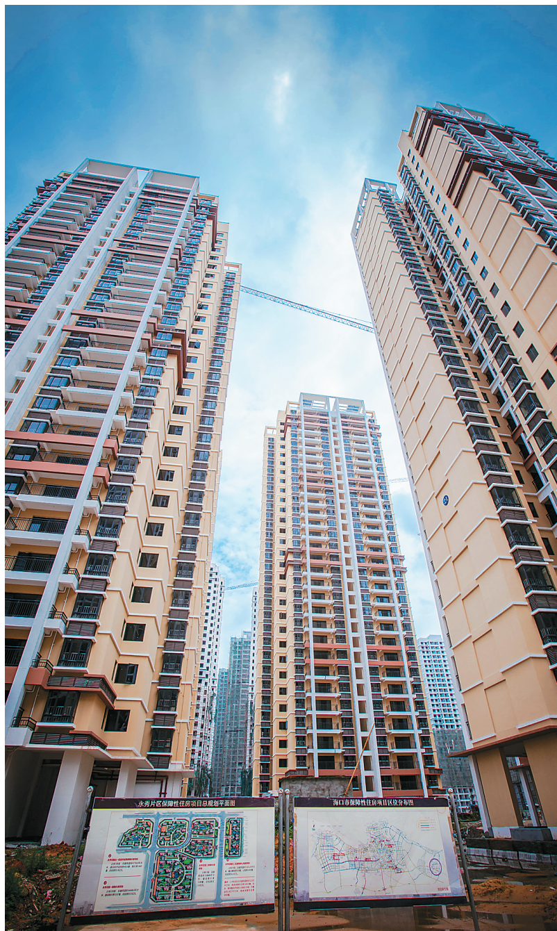
海口市住房保障体系永秀花园和永和花园。该小区共有廉租房、公租房、经济适用房、限价房一万余套，将解决近十中低收入百姓的住房问题。 显璜 摄
