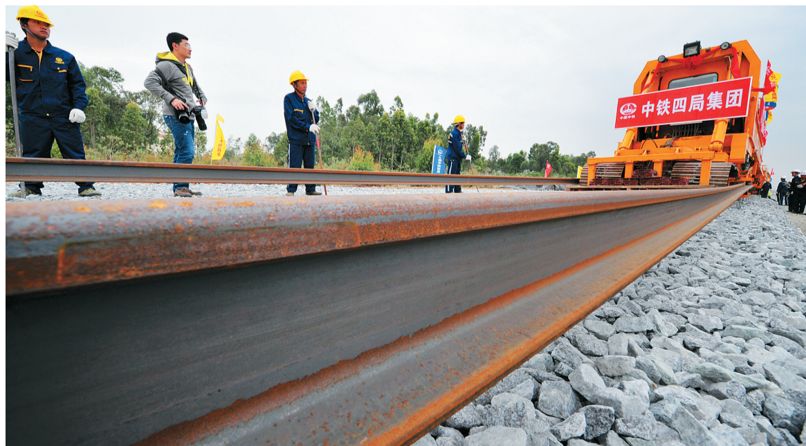
12月18日上午10时28分,东方火车站工地,西环高铁铺下第一对铁轨。 本报记者 古月 通讯员 叶坚 摄
