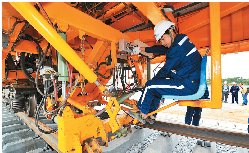
18日上午10时28分,在东方火车站工地,一根根轨枕从自动化铺轨机中有序“吐出”。
