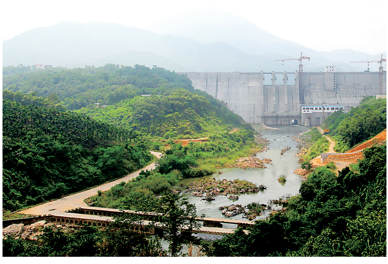
红岭水利主体工程基本完工。阿才 梁亚吉 摄
