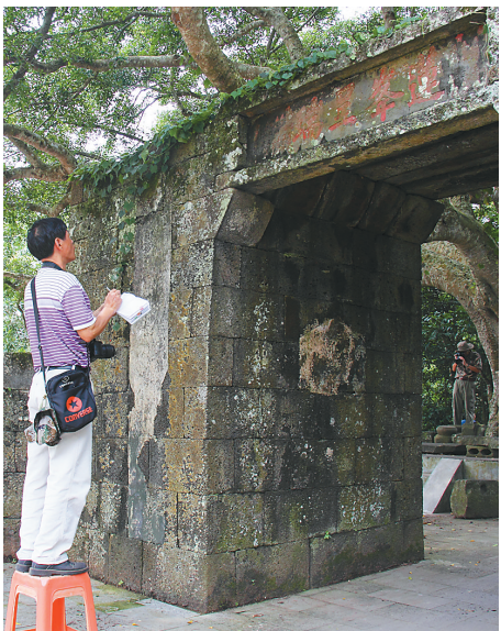
2013年9月走读羊山古村,网友“古水”测量和记录古村门。
