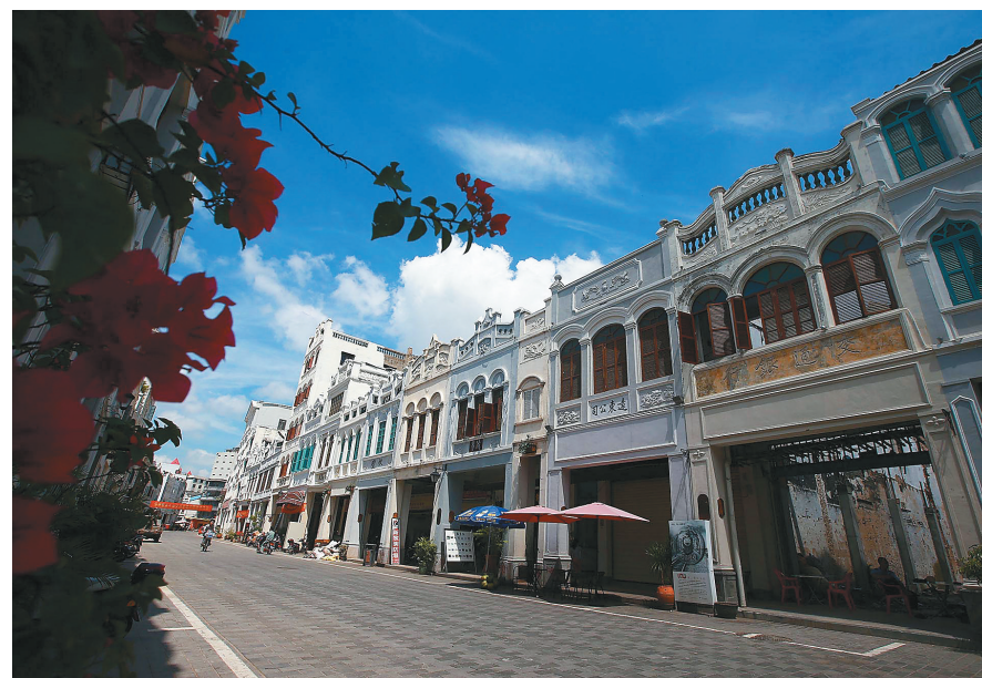
2014年8月22日，海口中山路，改造后面貌一新的骑楼建筑。 本报记者 张杰 摄
