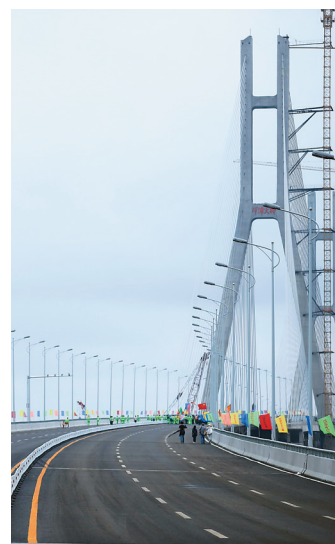
洋浦大桥。 本报记者 张茂 摄
