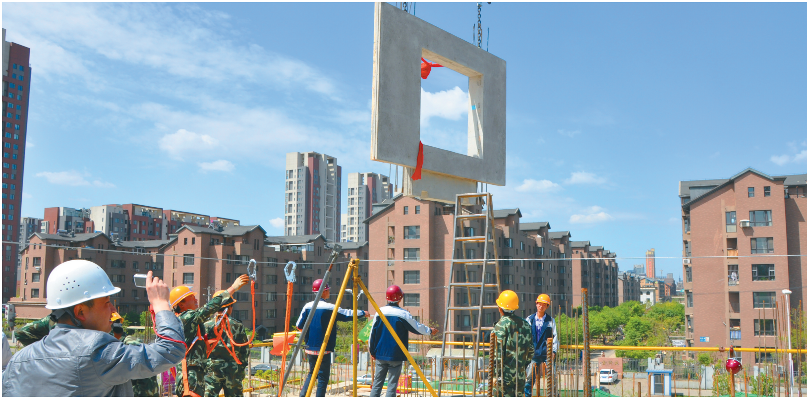
省外一建筑产业化工地正在进行内墙的吊装。资料图片
