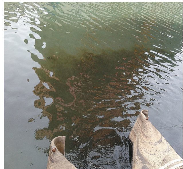
1月8日上午，海口和平大道与鸭尾溪交汇处桥下，一处污水截流管道不断往外冒黑水。 海报集团全媒体中心记者 王洪旭 摄
