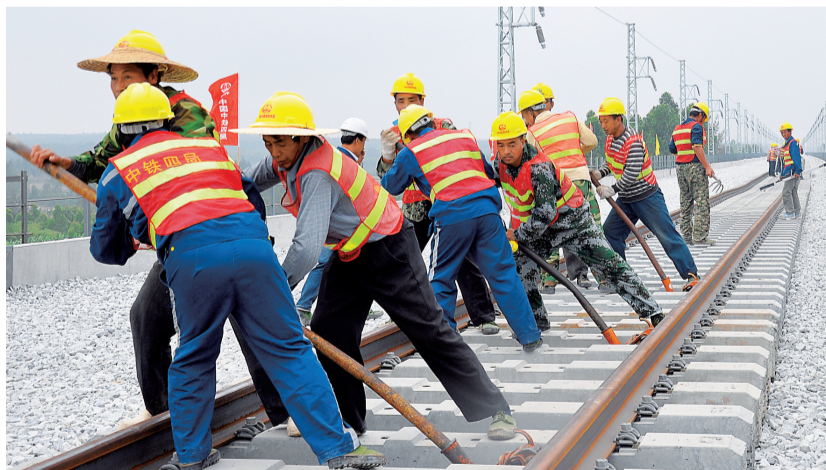
2月19日,新建海南西环铁路儋州段工人们在铺轨。本报记者 古月 通讯员 叶坚 摄
