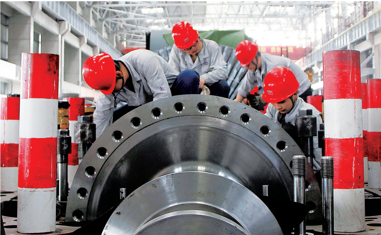
4月21日,国电西南部电厂,工人们在安装汽轮机配备组件。
