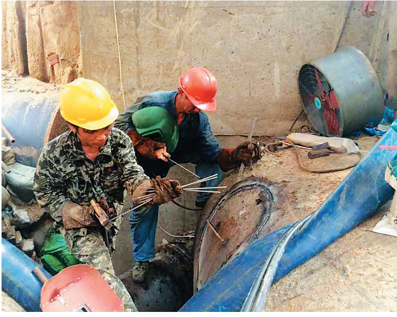
抢修工人正在对原水管漏点进行焊接。 本报记者 李佳飞 摄
