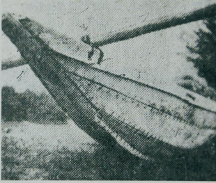
《中国船谱》一书中记载的海南岛缝合木船照片。这种木船使用椰子壳纤维搓制的绳子捆扎而成。
