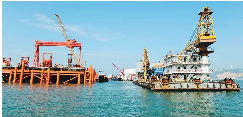
8月3日，中铁大桥局五公司的施工人员正在福建福平铁路平潭海峡公铁两用大桥最大航道桥N03主塔墩进行钻孔桩施工。目前，福平铁路重点控制性工程一平潭海峡公铁两用大桥的6个主塔全面开工建设。
