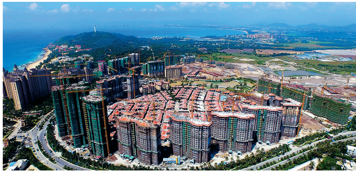
9月22日，陵水清水湾碧桂园·珊瑚宫殿项目正在加紧施工。
