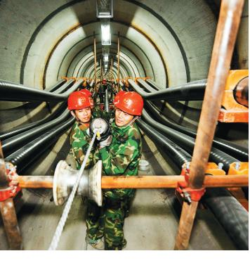
11月19日，电力工人在无锡市和畅路18米深的地下电缆隧道中铺设220千伏电缆。
