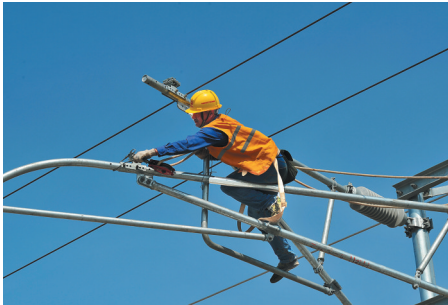
安装调试电力接触网。本报记者 古月 通讯员 叶坚 摄
