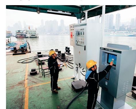
1月20日,经过一个多月的试运行后,重庆首个智能港口岸电系统在重庆朝天门港8号码头正式启用。按照测算,启用首个智能港口岸电系统的8号码头每年可替代柴油459吨,年减少碳排放量1480吨,减少燃油发电成本290余万元,具有良好的环保效益和经济效益。
