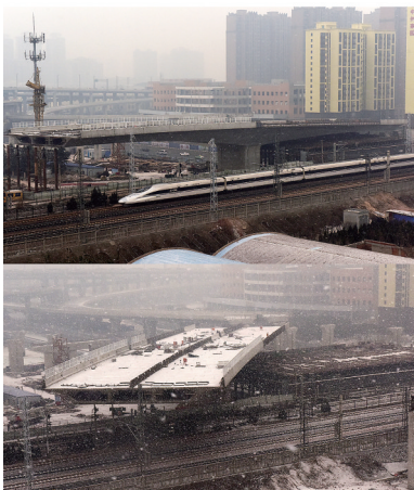
上图为:郑州市中心区跨陇海铁路线桥主桥转体前火车通过的场景。下图为:郑州市中心区跨陇海铁路线桥主桥转体进行中(1月22日摄,拼版照片)。
