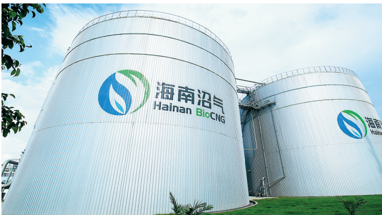
澄迈海南车用沼气新能源应用示范项目沼气罐。目前,该项目日处理约500吨禽畜粪污、甘蔗渣等有机废弃物,日产出3万立方米车用沼气,沼渣沼液还可以充当肥料,反哺当地生态农业建设。
