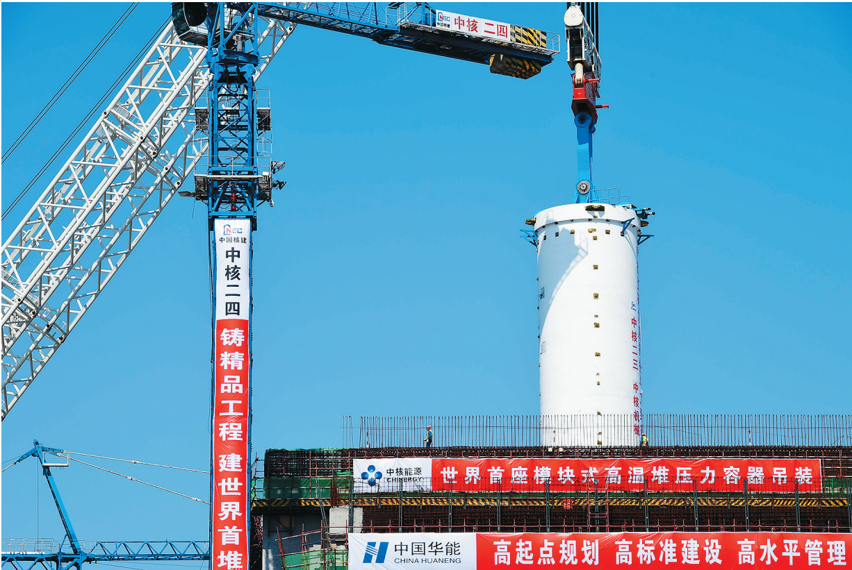
3月20日，在华能山东石岛湾核电厂，反应堆压力容器成功吊装进入核岛。 新华社记者 郭绪雷 摄
