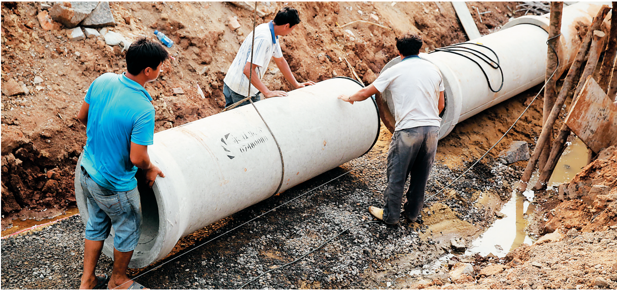
海口市红城湖环湖路开工 日前,工人在海口市红城湖环湖路施工。海口市红城湖环湖路起于红城湖路,终点与大英山西二路相交,环绕红城湖而建,全长约1672米,设计行车速度30m/h。项目工程费用为4163.68万元。环湖路的建成将有效完善大英山新城市中心片区路网,缓解海口城市交通压力。 本报记者 张茂 摄
