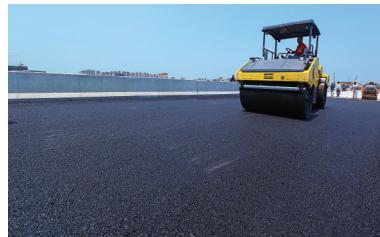
本报海口5月7日讯 (记者许春媚)今天上午11时许,大型作业车开上海口市海秀快速路工程一标段的高架桥桥面,开始沥青摊铺作业(上图,本报记者张茂 摄)。据了解,这是海秀快速路高架桥主桥首次进行试验性沥青摊铺,意味着主桥的施工又进入一个关键性时段,距7月30日实现主桥通车的目标迈进了一大步。
