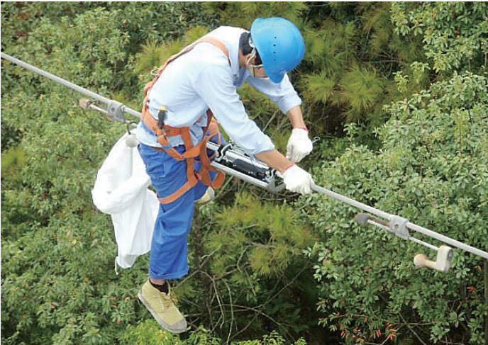
供电人员在安装雷电监测终端。(海南电力技术研究院 供图)
