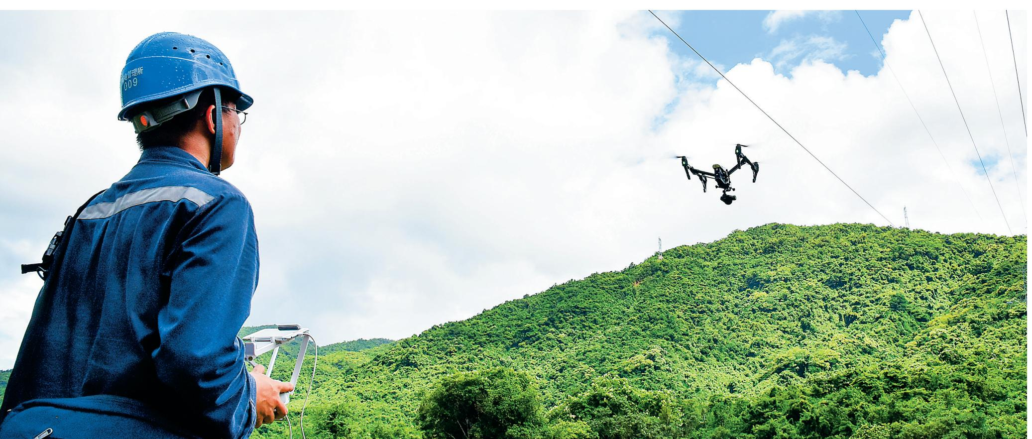
无人机巡检输电线路
