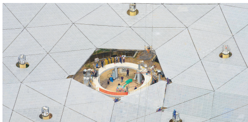
图为工作人员在安装FAST的最后一块反射面板。 新华社发
