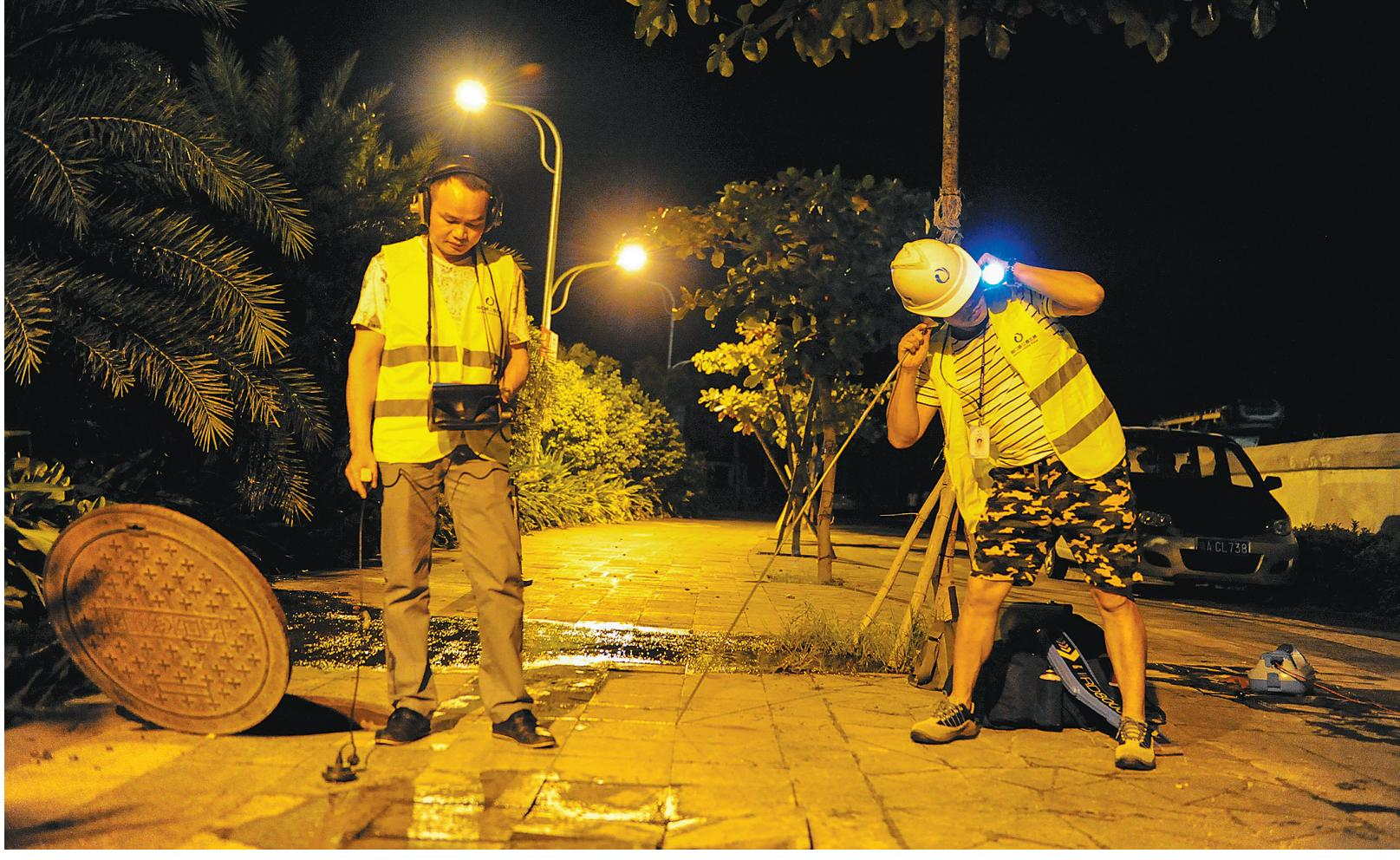
7月28日凌晨，在海口市碧海大道，听漏工苏英岱(左)和王闻用“听诊器”巡查水管漏点，解决居民反映的水压变小问题。
