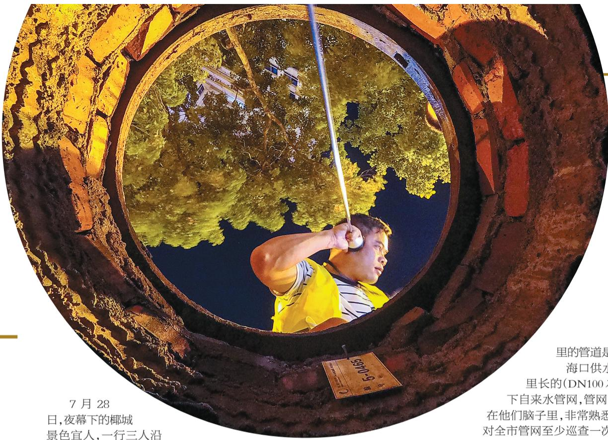
听漏工凭借良好的听漏技能,不用下井也能将井内漏水情况了然于胸。
