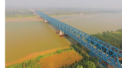
黄大铁路黄河特大桥。当日，黄(骅)大(家洼)铁路黄河特大桥主桥工程全部完工。大桥位于山东省利津县境内，距黄河入海口约110公里，主桥全长960米，为黄大铁路唯一的重难点控制性工程。 新华社记者 邢广利 摄
