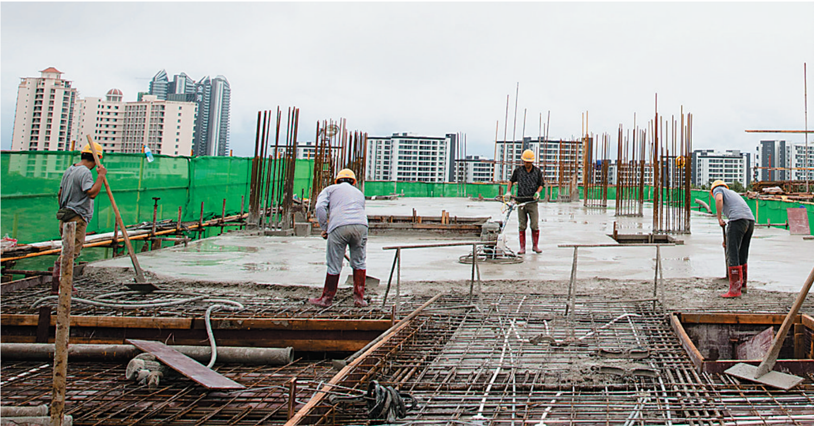
9月23日，南海博物馆南区，工人正在进行最后一层楼板混凝土浇筑。 本报记者 宋国强 摄
