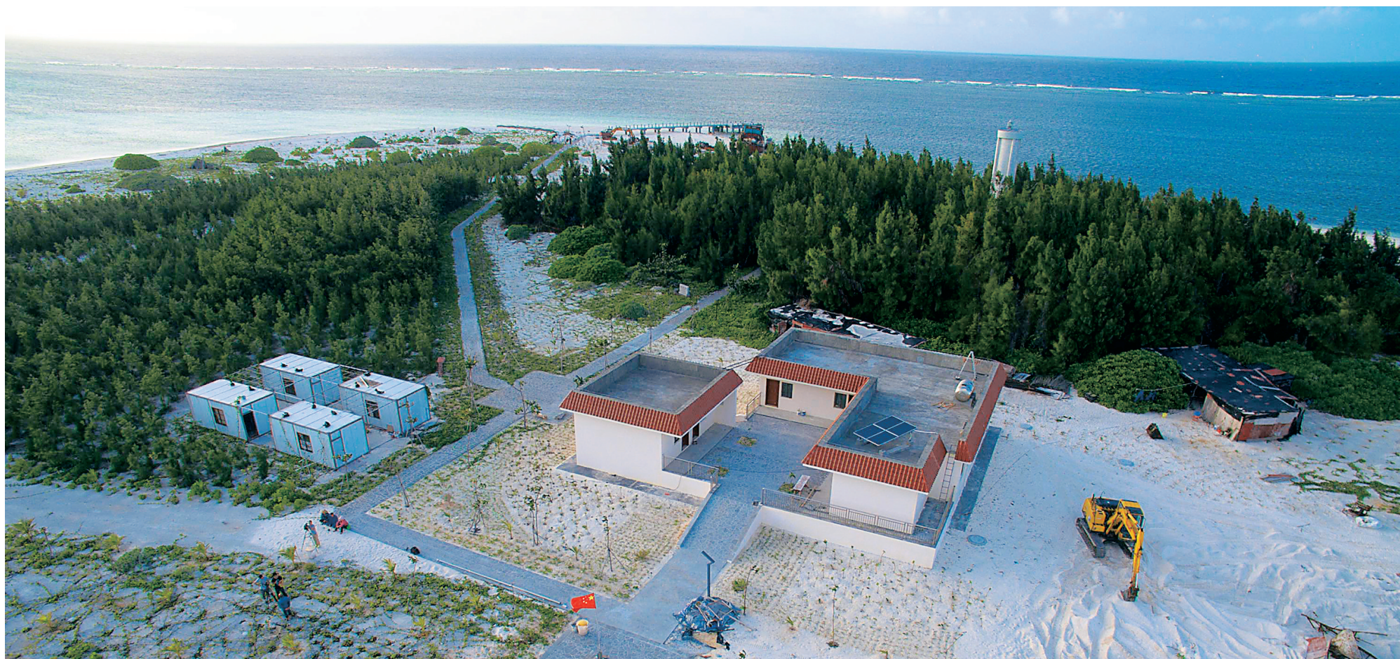
完成建设的三沙市西沙洲简易码头。本报记者 宋国强 摄
