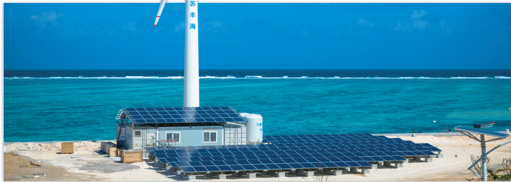
2月4日，风光互补海水淡化设备在三沙市赵述岛安装完毕。本报记者 宋国强 摄
