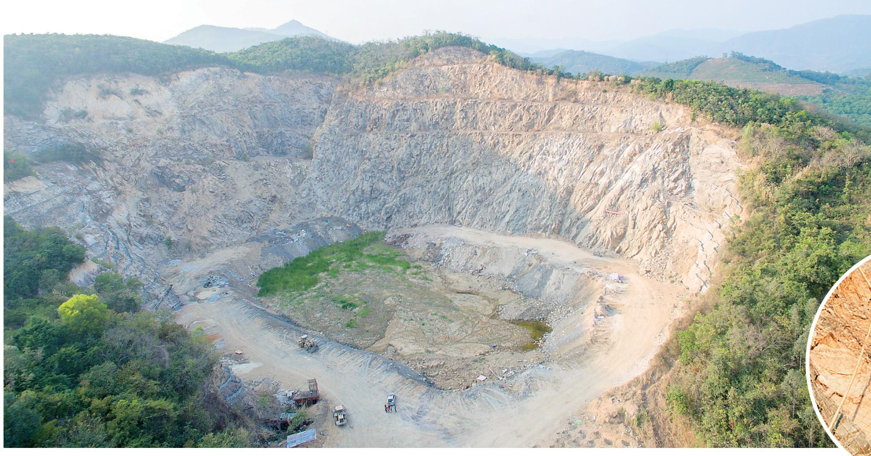
3月10日，三亚半岭温泉附近1号矿坑，裸露受损的山坡上挖出了一道道沟槽，等待工人下一步的修复。
