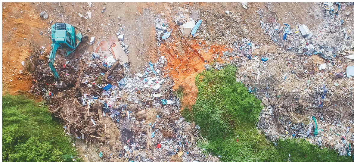
8月16日,东线高速万宁市礼纪镇群坡出口附近,农联村二水村民小组外的垃圾堆放场,挖掘机正在清运垃圾。
