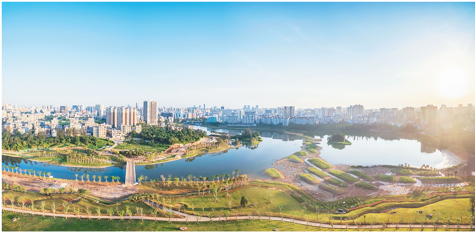
今年前7月，在全国74个重点城市中，海口的空气质量排名第一。图为建设中的海口市凤翔公园，良好的生态环境为海口空气质量的持续优良奠定了基础。 本报记者 李幸璜 摄
