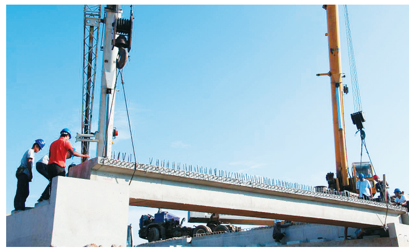
工人们正在架设桥体托架。 通讯员 陶畅 摄
