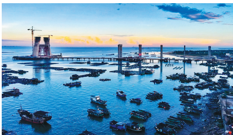
建设中的铺前大桥,周边渔排星罗棋布。 通讯员 蒋聚荣 摄
