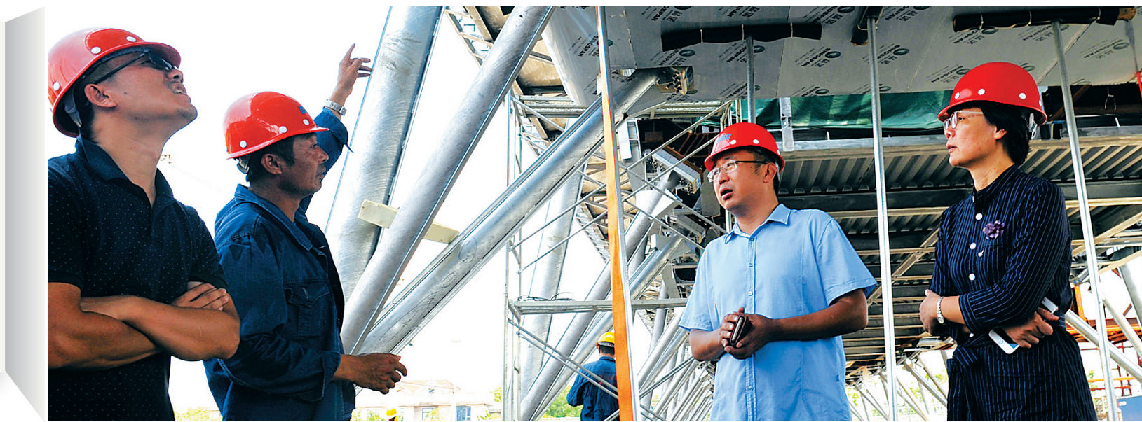
中国电子进出口总公司费拉兹站建设项目组经理曹虹(右一)和副经理焦阳(右二)在位于上海的预拼装现场检查施工进度。 新华社记者 张建松 摄
