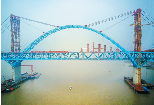
世界最大跨度公铁两用钢拱桥主拱合龙
