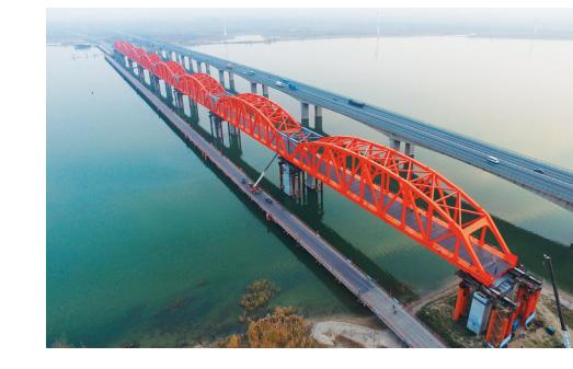
11月9日拍摄的顶推完工的京张高铁官厅水库特大桥。日前，京张高铁官厅水库特大桥拱型八孔钢桁梁顶推成功，这标志着该桥建设进程过半。据介绍，官厅水库特大桥全长9077米，是京(北京)张(张家口)高铁重要节点工程。新华社发
