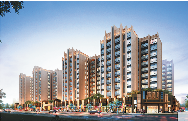
灵山·海建家园项目(正在建设)
