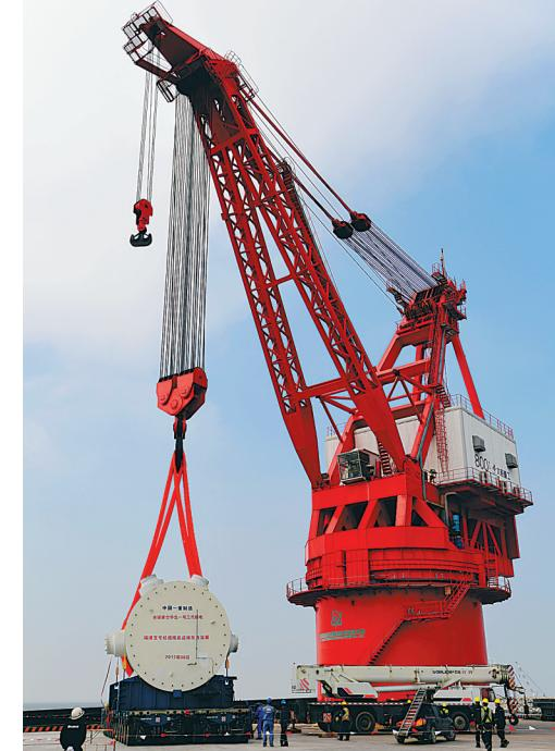
1月17日，在福清核电大件码头，工作人员将福清核电5号机组反应堆压力容器吊运到运输车上运往反应堆。
