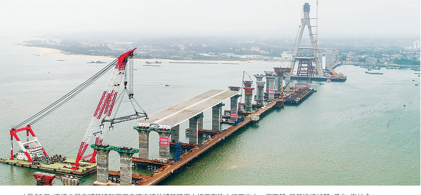
1月26日，连接文昌市铺前镇和海口市演丰镇的铺前跨海大桥正在热火施工当中。据了解，目前该桥桩基、承台、墩柱全部完工；箱梁总共72跨，已完工55跨；累计完成投资约42亿元，完成总量的82.7%。
