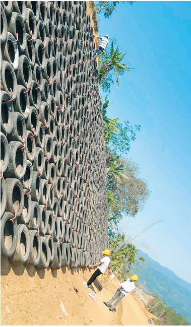
琼乐高速利用废旧轮胎进行生态护坡。本报记者 陈雪怡 通讯员 高芳植 张璐 摄
