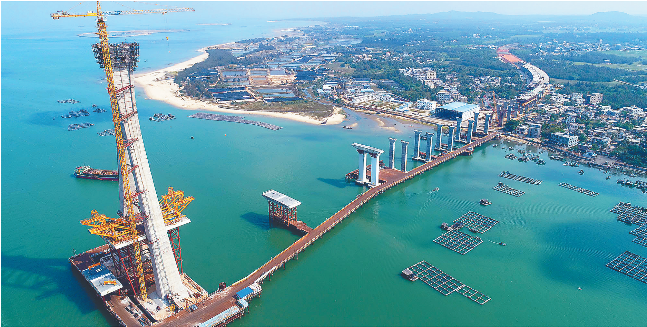
3月27日,铺前大桥项目主墩已完成桩基、承台、塔座施工,预计3月底完成封顶工作。本报记者 张杰 摄
